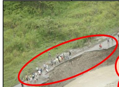
洪水によるルガサ橋の崩壊 洪水による道路洗掘
