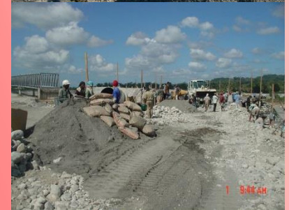
ナタボラ橋の徒渡場復旧工事 （現地政府＋譲与器材）
