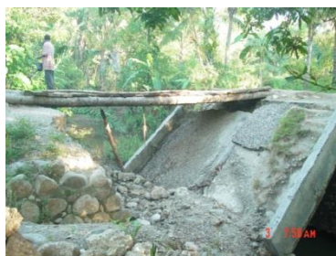
洪水によるルガサ橋の崩壊 洪水による道路洗掘
